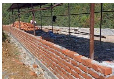
新たな分別場建設現場
